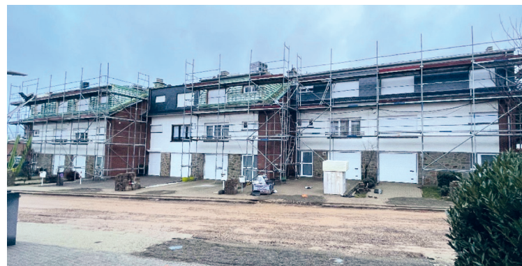
Rénovation des logements sis Rue des Myosotis à Welkenraedt
